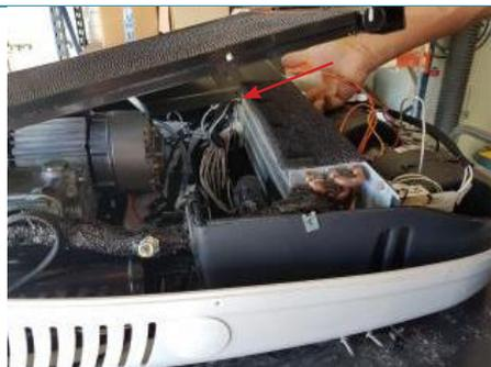
5. Soulever l'échangeur évaporateur en le prenant côté opposé du thermostat.
